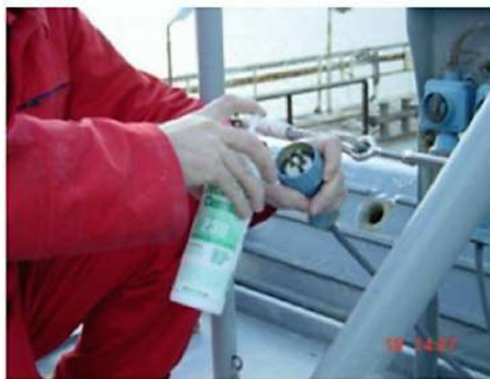
Slika 5.9. Primjena inhibitora kod zaštite električnih kontakata [22]
