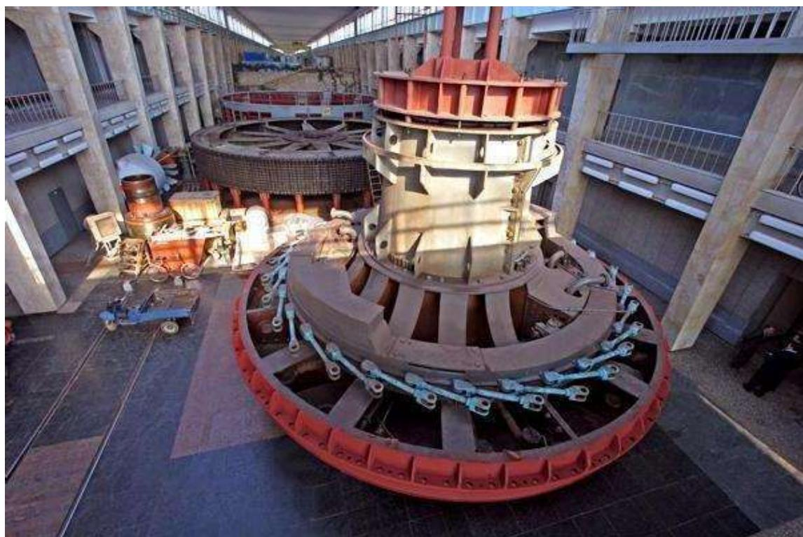
*Slika 2.8. Rotor hidroelektrane Saratov u Rusiji [9]*
