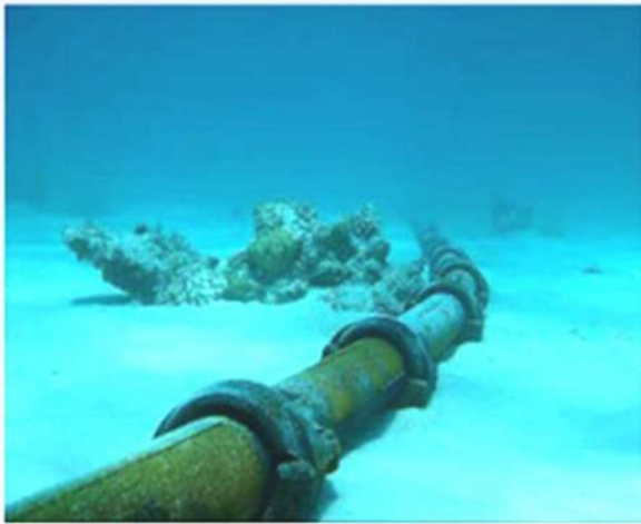
Slika 7.7: Kabel s ljuskom od lijevanog željeza i instalacija ljuske od lijevanog željeza na kabel (uz nepoštivanje današnjih sigurnosnih mjera) [1]
