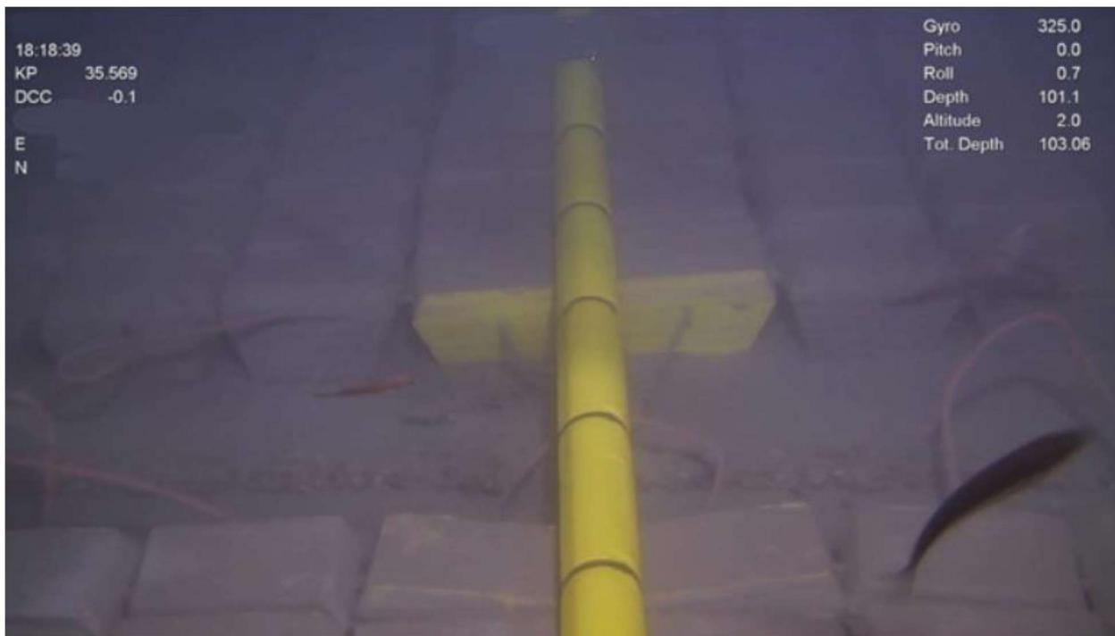
Slika 7.8: Prikaz kabela s betonskim (blok) madracem [1]
