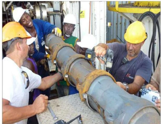
Slika 7.7: Kabel s ljuskom od lijevanog željeza i instalacija ljuske od lijevanog željeza na kabel
