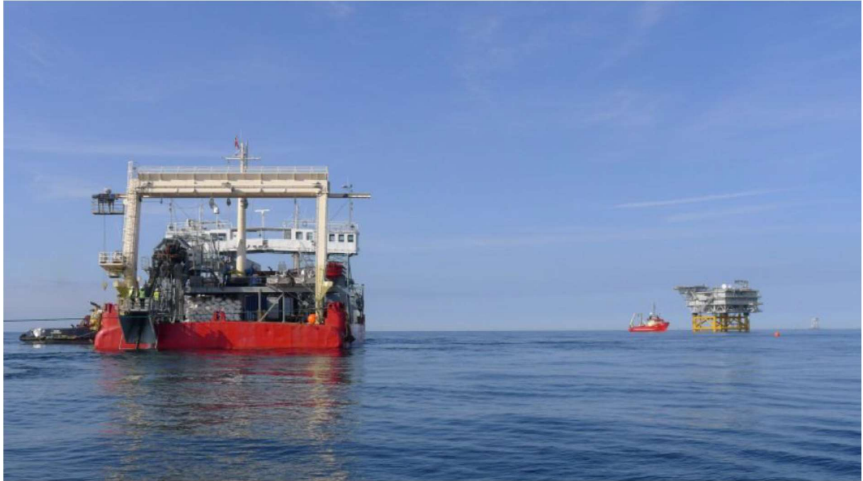
Slika 7.2: Teglenica za polaganje kabela (CBL) [1]
