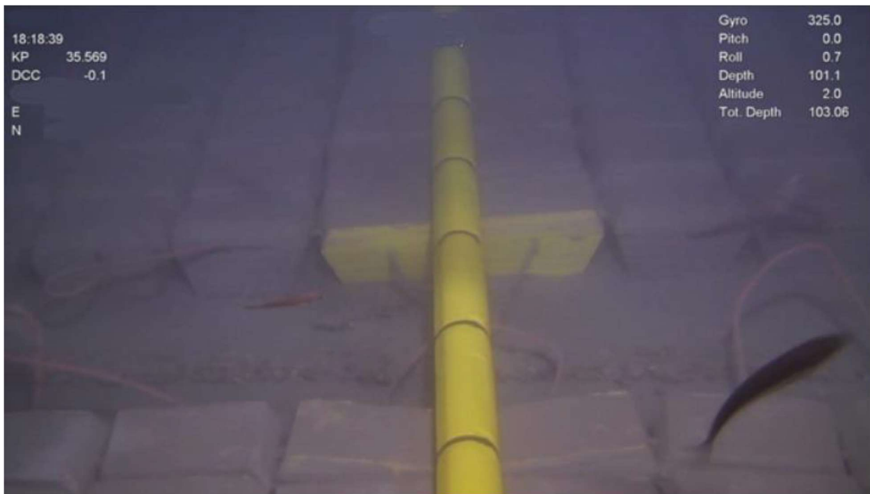
Slika 7.8: Prikaz kabela s betonskim (blok) madracem [1]
