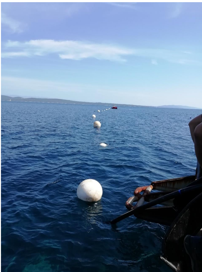
Slika 4.2. Postavljanje kabela s plutačama
