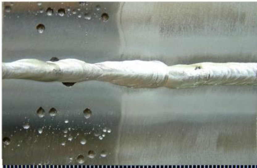
Slika 3.5 Rupičasta korozija čelika [8]
