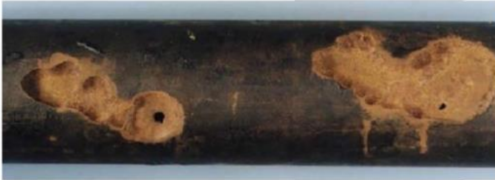
Slika 3.22 Oštećenje uslijed korozije djelovanjem lutajućih struja [8]
