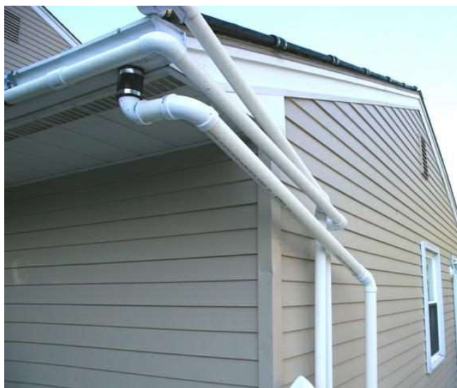
Slika 3.6. Postavljene dovodne cijevi [11]
