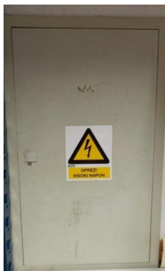
Slika 7.3. Oznaka na opasnost od električnog udara na GRO-u
