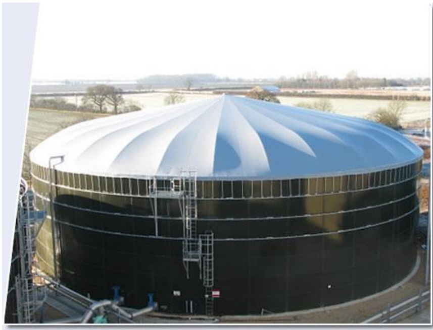
Slika 6.6 Membranski spremnik digestata
