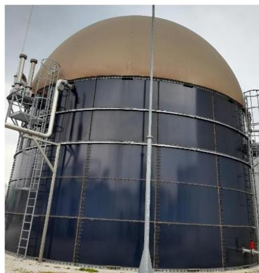
Slika 4.3 Digestor s nepropusnom mebranom za skladištenje bioplina [19]
