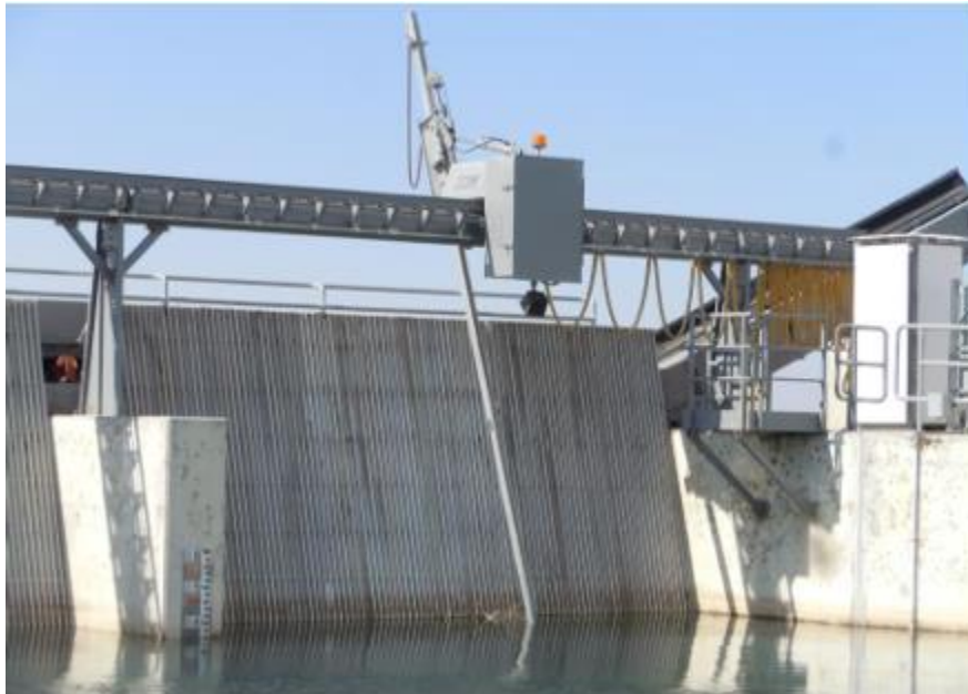
Slika 3.1. Zaštitna rešetka s krajnjim nosačem [5]
