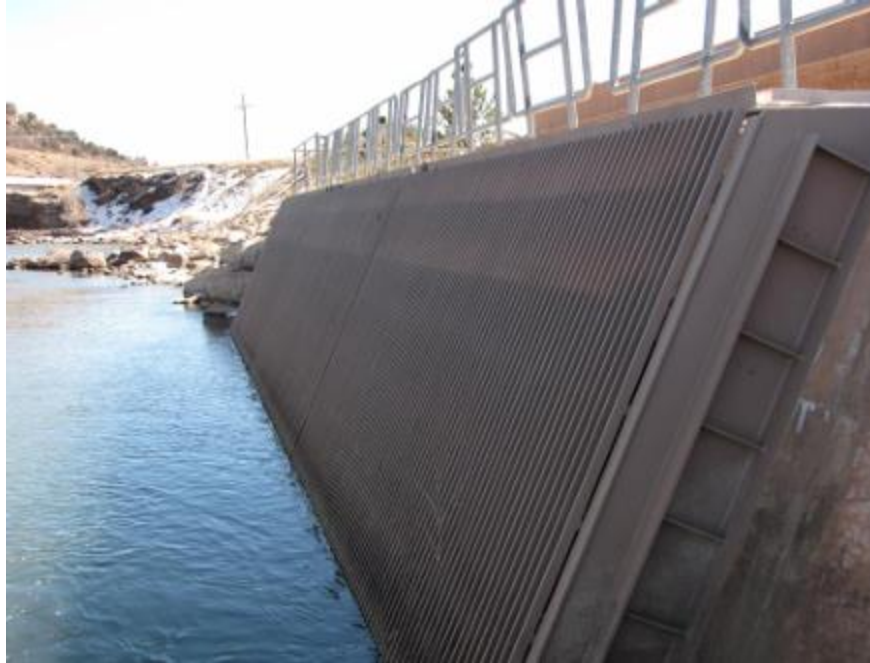
Slika 3.2. Zaštitna rešetka s bočnim nosačem [5]
