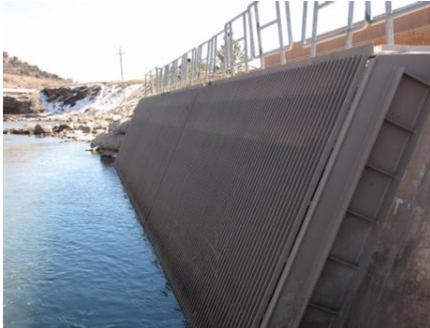
Slika 3.2. Zaštitna rešetka s bočnim nosačem [5]
