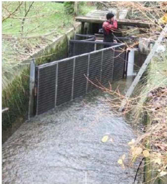
Slika 4.1. Izrada eksperimentalne rešetke [9]
