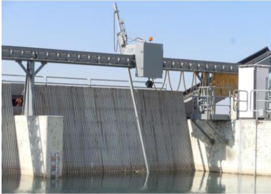
Slika 3.1. Zaštitna rešetka s krajnjim nosačem [5]
