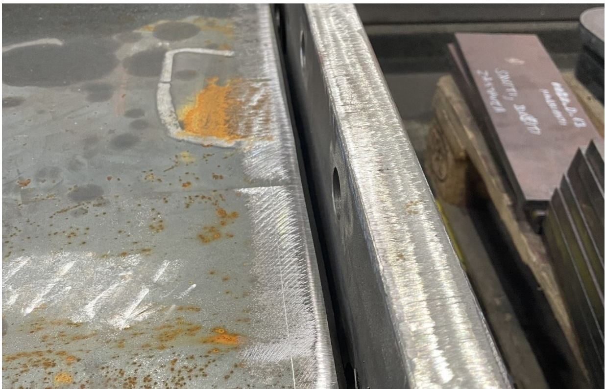
Slika 9.2. Priprema površine i oblikovanje elemenata za zavarivanje
