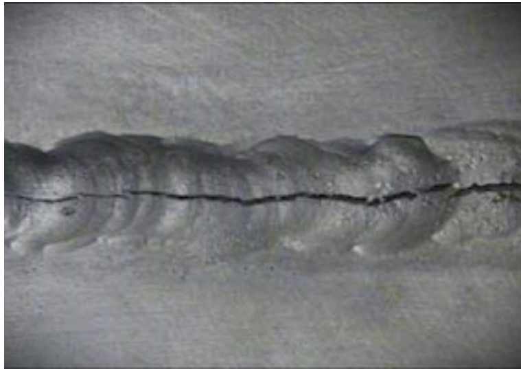
Slika 8.1. Topla pukotina, lice zavarenog spoja
