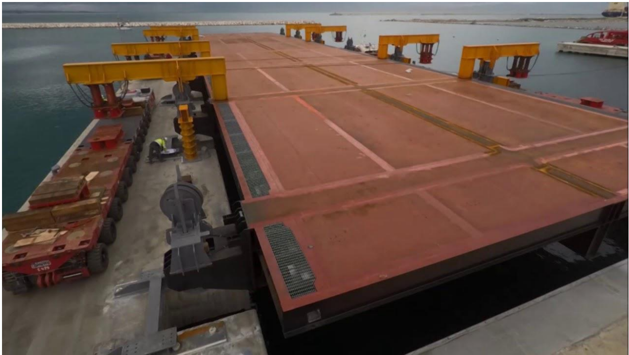
Slika 1. Prikaz sinkro-lifta u krajnjem vertikalnom položaju platforme
