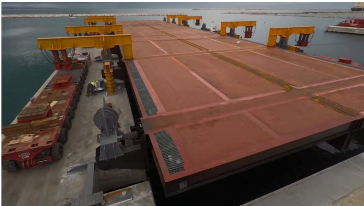
Slika 1. Prikaz sinkro-lifta u krajnjem vertikalnom položaju platforme
