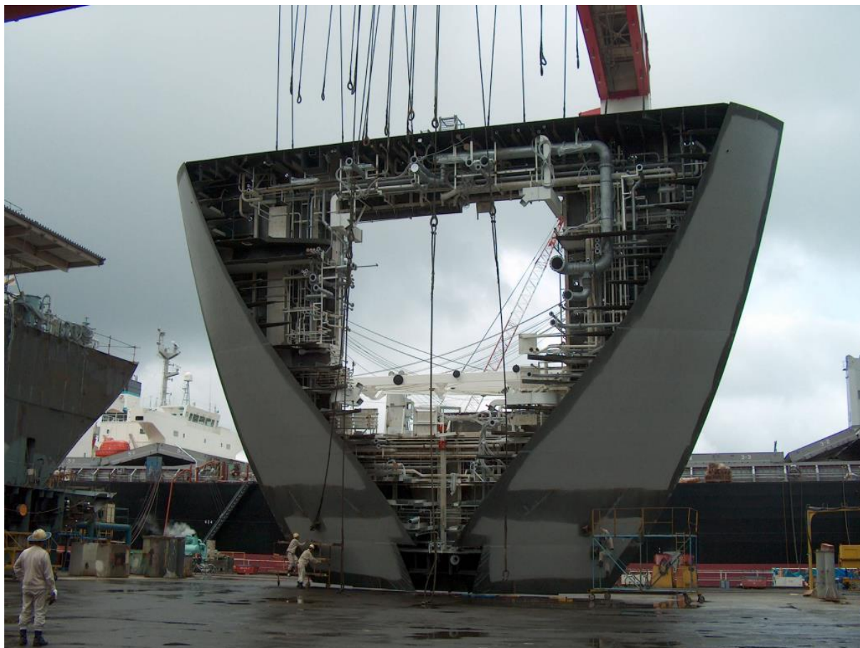
Slika 4.2. Opremanje sekcije strojarnice
