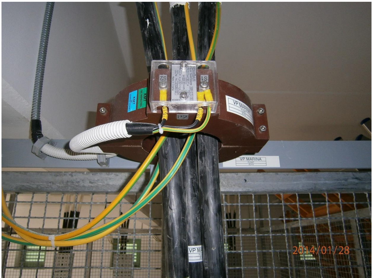
Slika 5.2. Obuhvatni transformator
