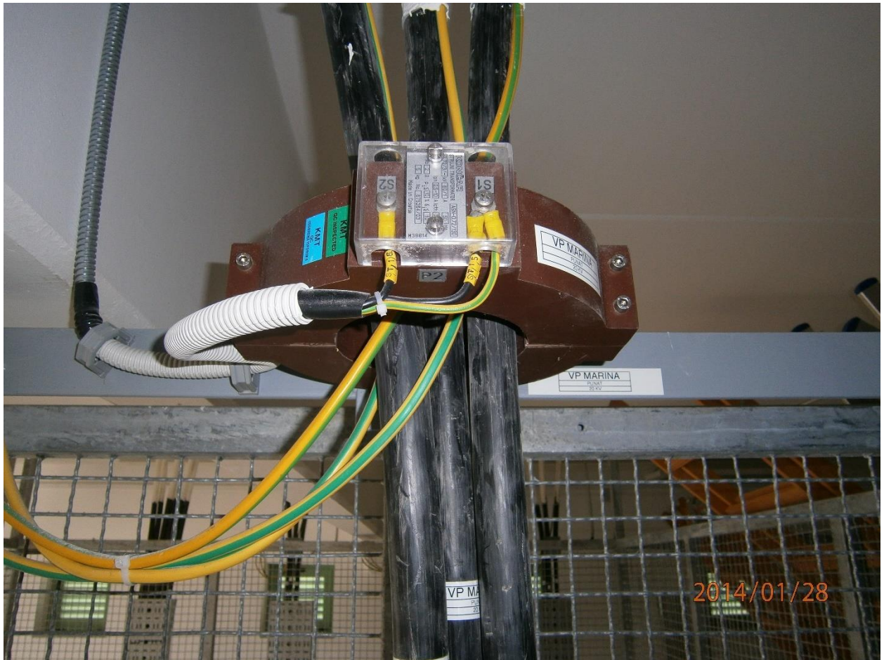
Slika 5.2. Obuhvatni transformator
