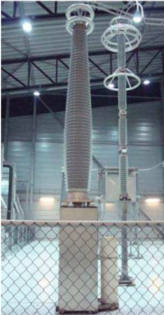
Slika 4.22. Unutrašnji priključci za HVDC kabele, masom impregnirane kabele (lijevo) i ekstrudirane kabele (desno). Mali cilindar za spremnik ulja je pričvršćen za postolje lijevog priključka [13]
