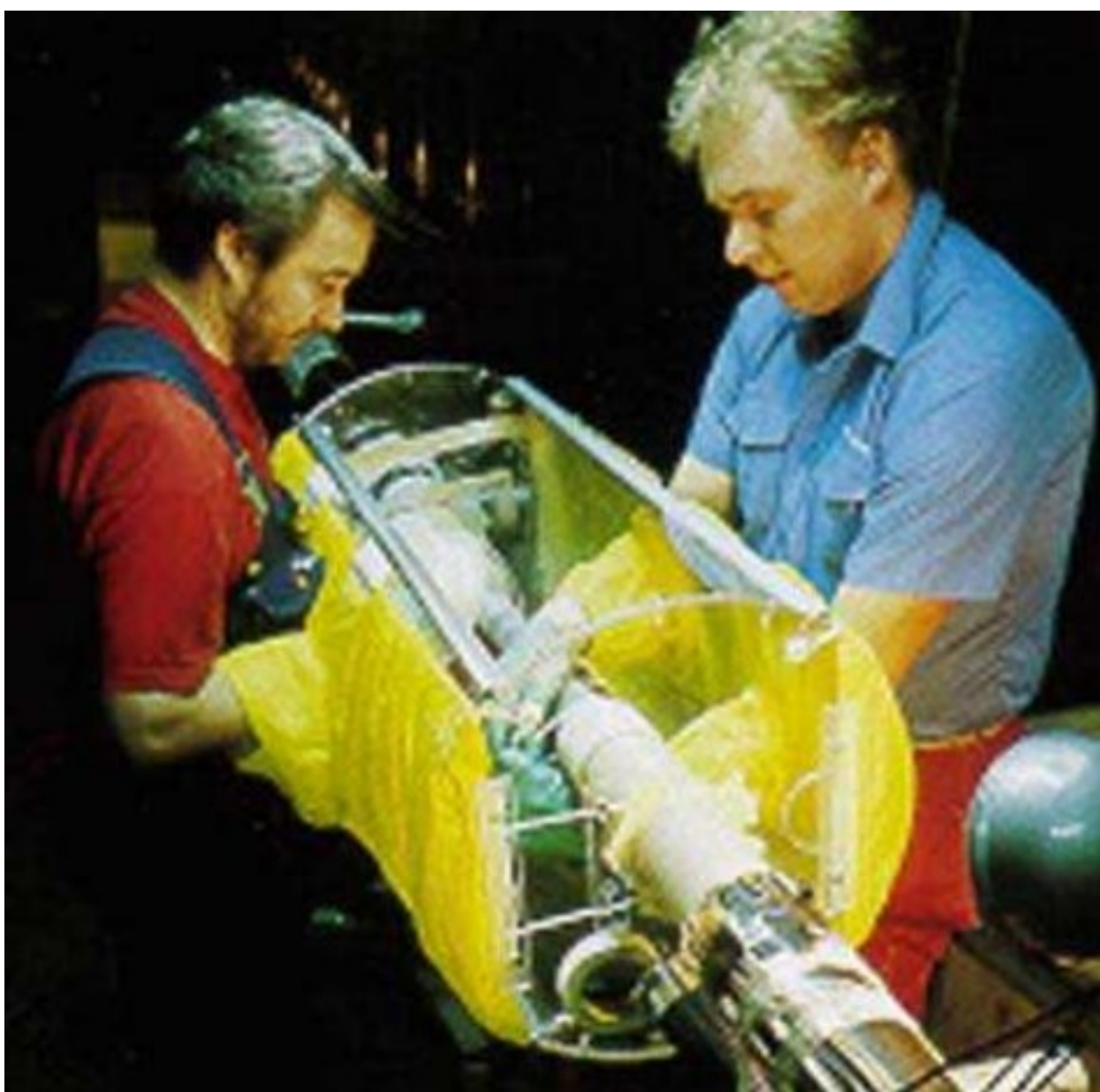
Slika 4.15. Primjena izolacije spoja od XLPE materijala u čistim uvjetima (podaci ustupljeni od strane tvrtke ABB, Švedska) [13]
