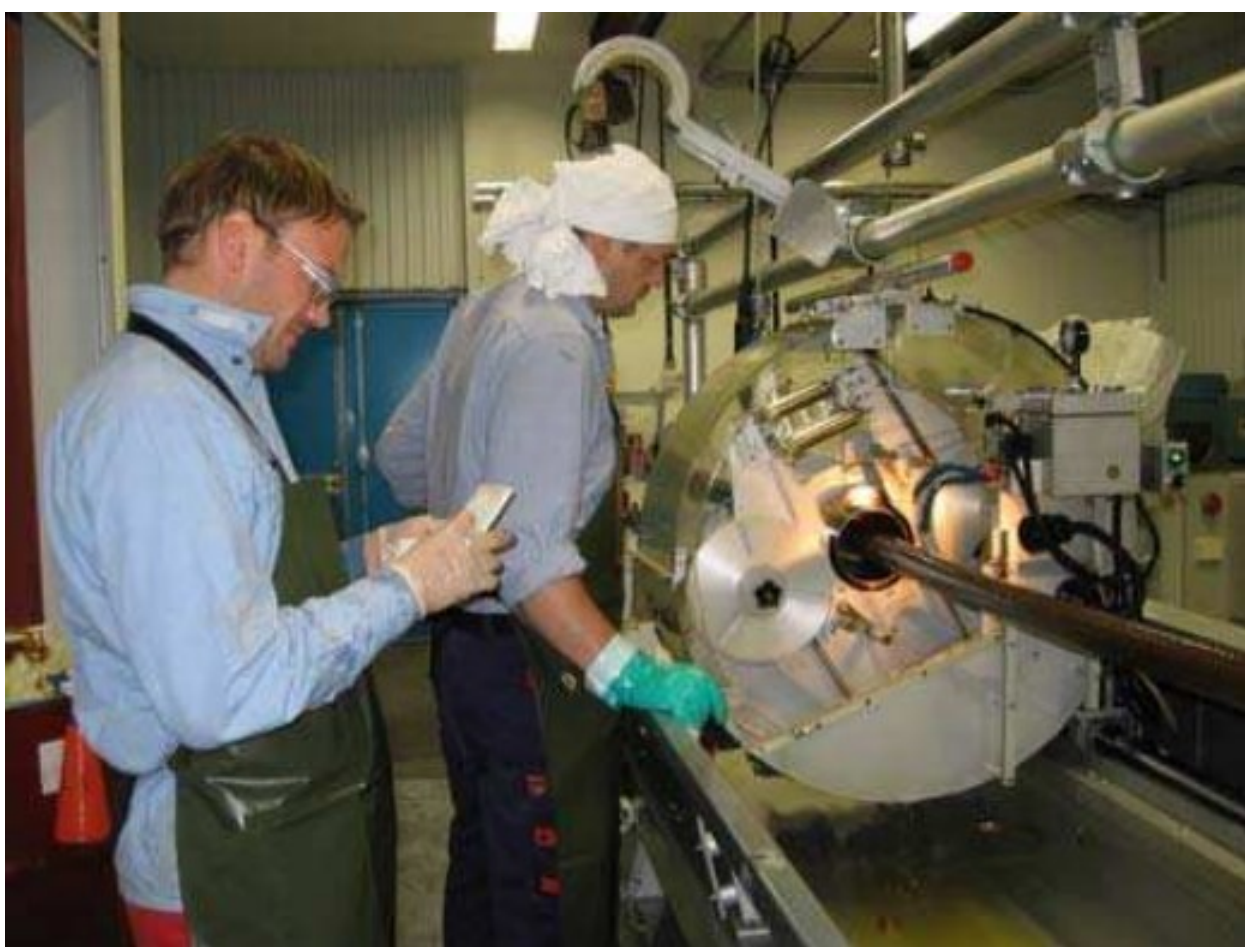
Slika 4.16. Primjena izolacije od papira za fleksibilni spoj pomoću poluautomatskog stroja za preklapanje (podaci ustupljeni od strane tvrtke ABB, Švedska) [13]
