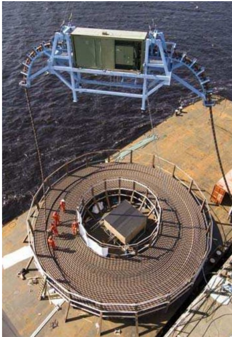
Slika 4.8. Namatanje podmorskog energetskeg kabela [13]
