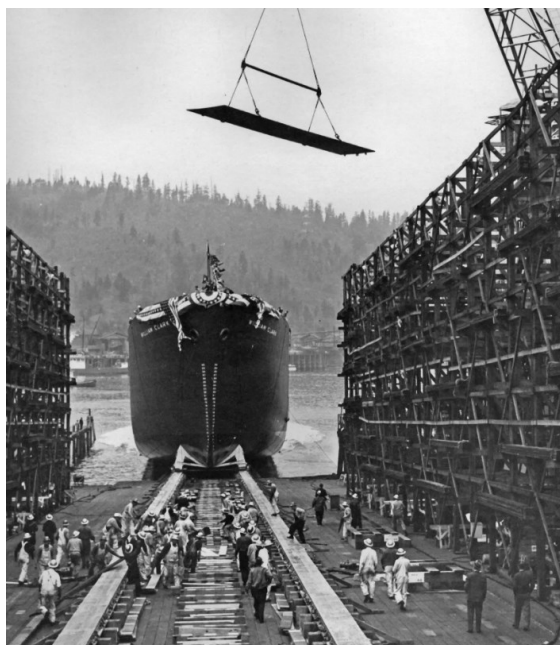
Slika 6.1. Uzdužno porinuće na kosom navozu
