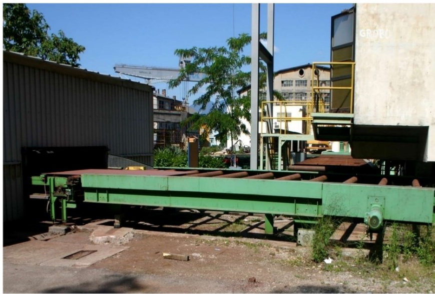
Slika 4.3.1. Transport limova nakon predobrade u radionice obrade (3. Maj) [3]
