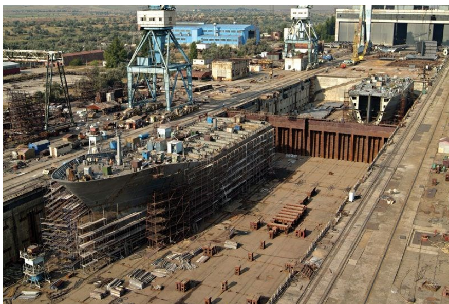
Slika 6.3. Montaža na suhom doku
