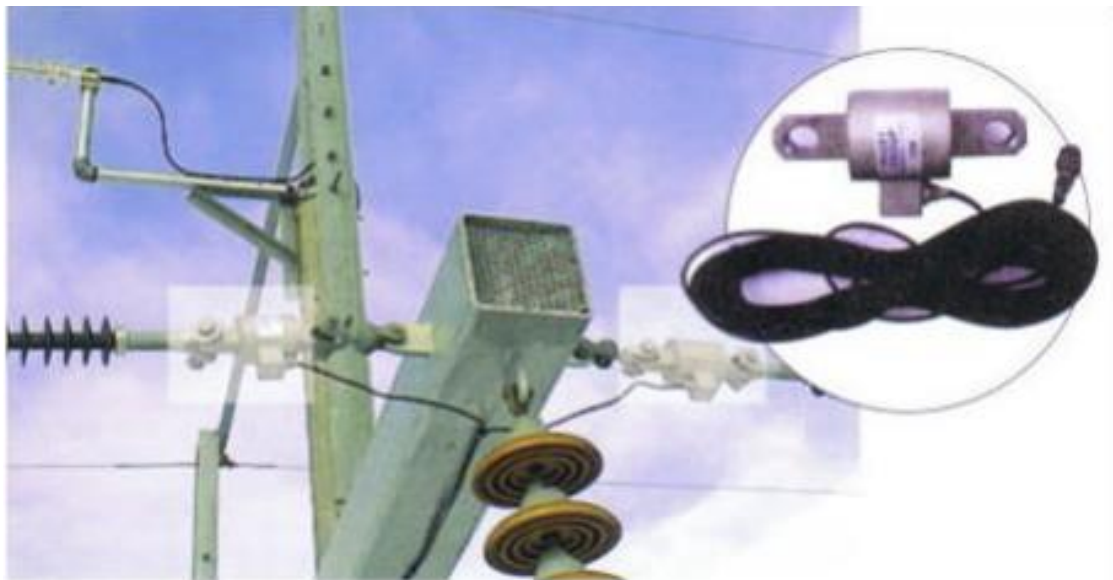
Slika 5.10. Mjerenje naprezanja – mjerne ćelije postavljene na dead-end strukturama [11]
