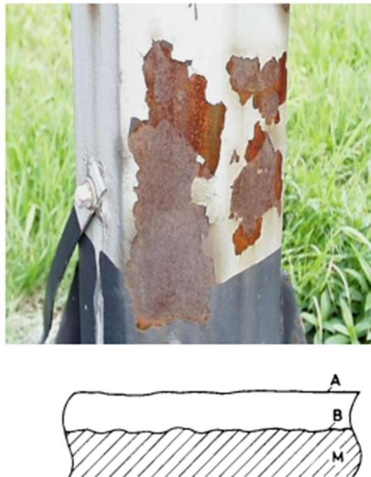
Slika 4.1: Ravnomjerna opća korozija čeličnog rasyjetnog stupa [10]
