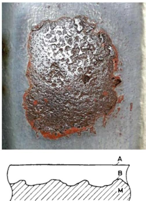
*Slika 4.2: Neravnomjerna opća korozija čeličnog rasyjetnog stupa [10]*
