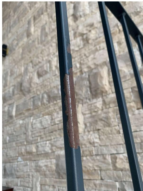
*Slika 6.18: Korozija kod zaštite plastifikacije*
