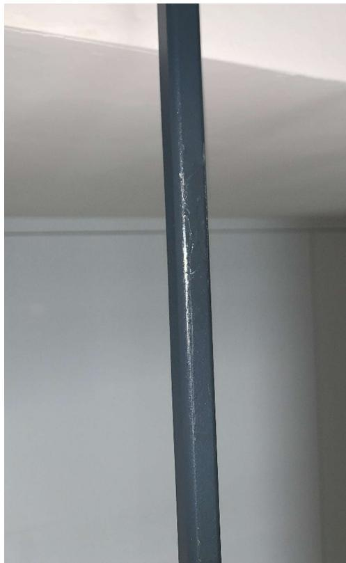
*Slika 6.16: Oštećenje zaštitom plastične folije*
