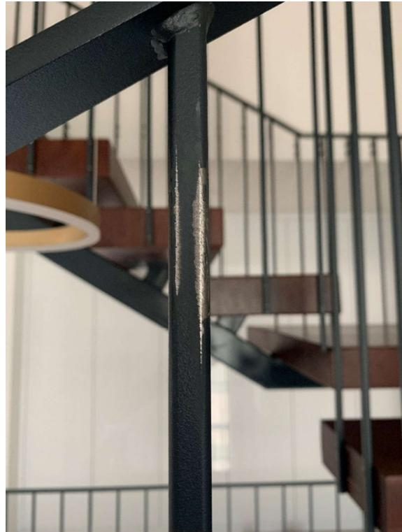
*Slika 6.17: Oštećenje mehaničkim trenjem*
