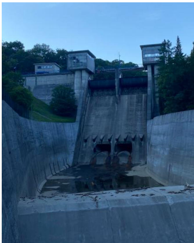
Slika 2.3. Brana hidroelektrane Rijeka
