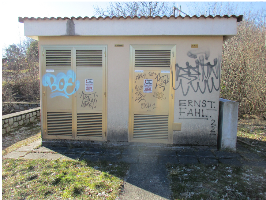
Slika 2.2. Transformatorska stanica tip KTS [4]
