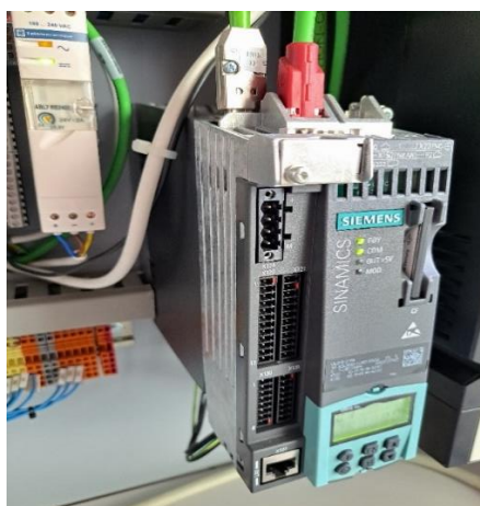
Slika 4.2.1. Frekvencijski pretvarač SINAMICS-S120
