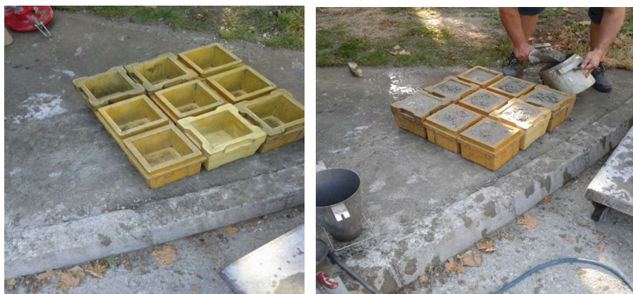
Slika 29 Prazni pripremljeni kalupi i napunjeni svježim betonom
