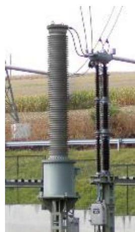
Slika 3.26. Naponski transformator izoliran plinom SF<sub>6</sub> [20]
