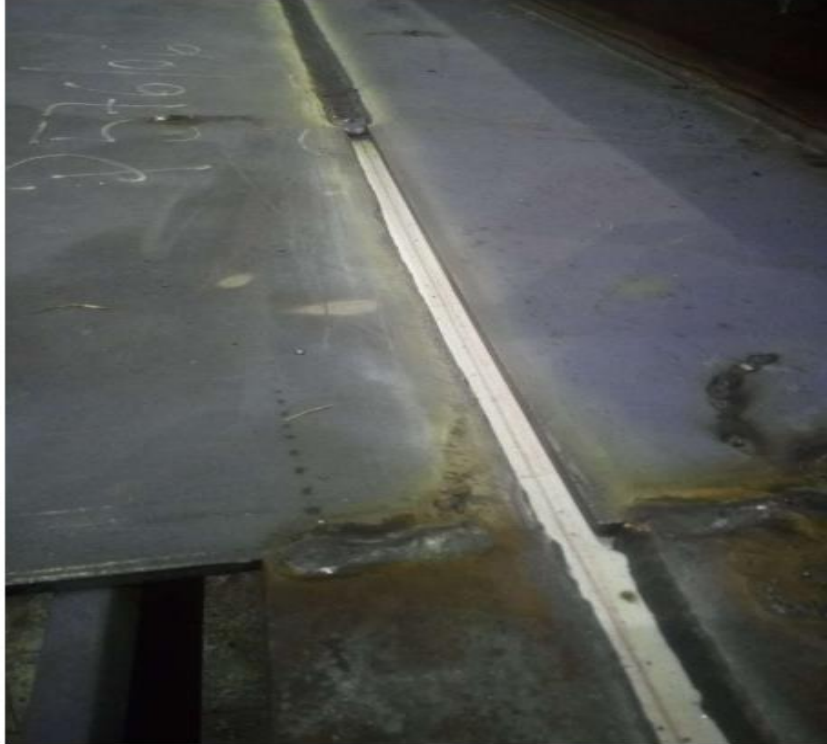
Slika 8.4. 2: Priprema za sučeljni spoj
