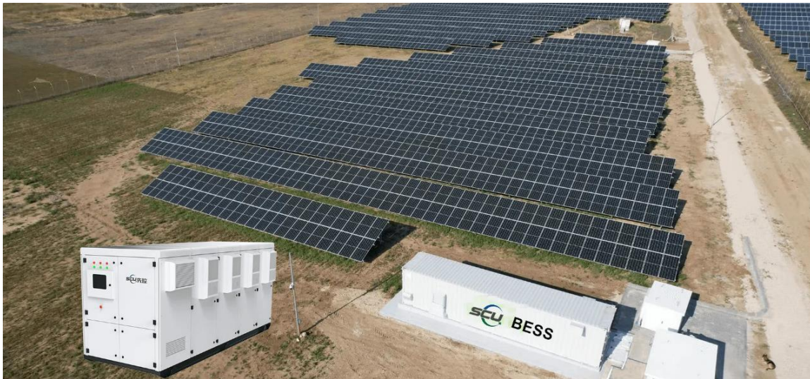
Slika 5. 15 FN elektrana potpomognuta baterijskim sustavom pohrane [11]
