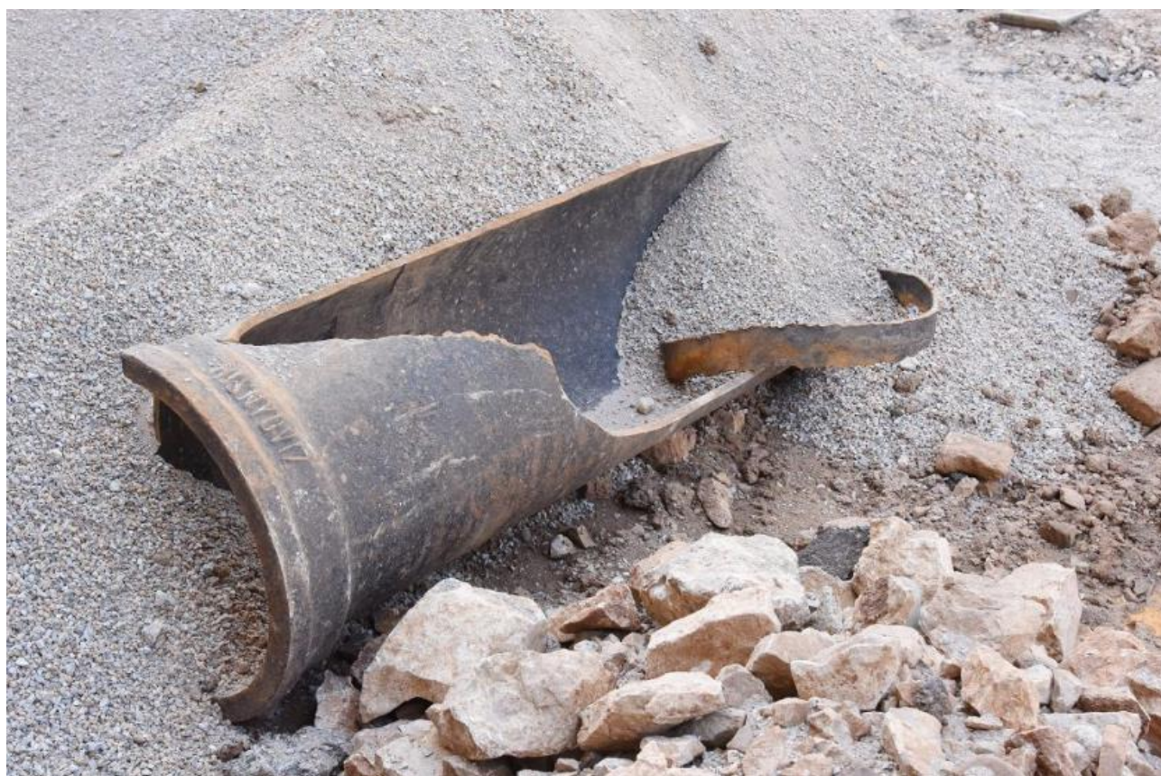
Slika 2.1 Prikaz puknute cijevi [3]
