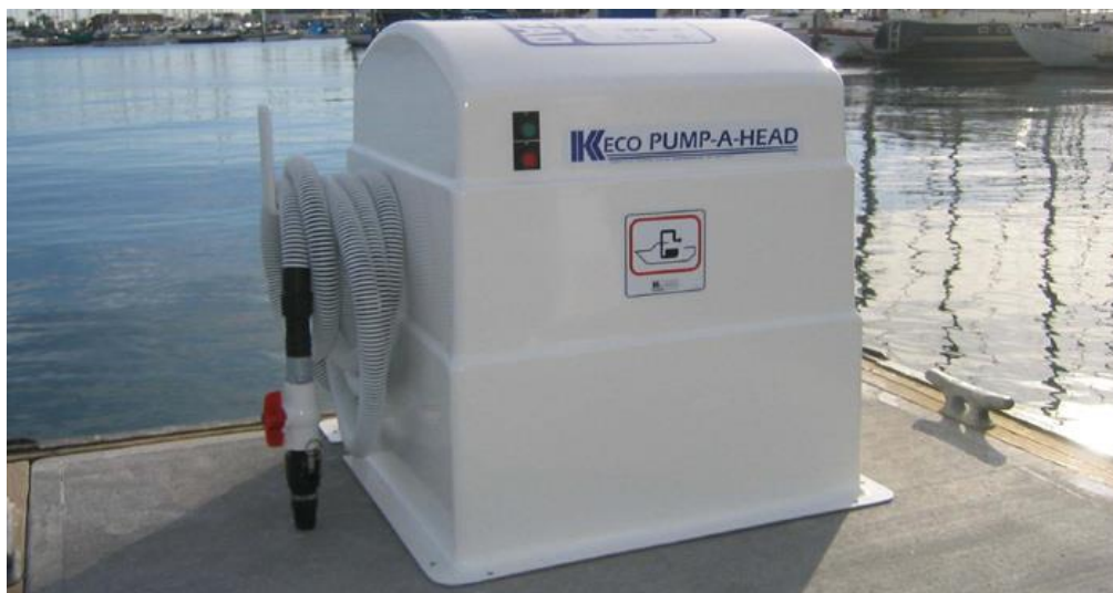
Slika 3022 - Pump-out sustav u marini[32]
