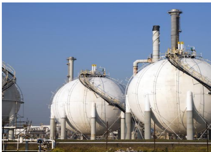
Slika 3.7 Spremnici zemnog plina
