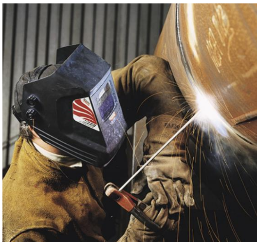
Slika 14. Zavarivanje REL postupkom
