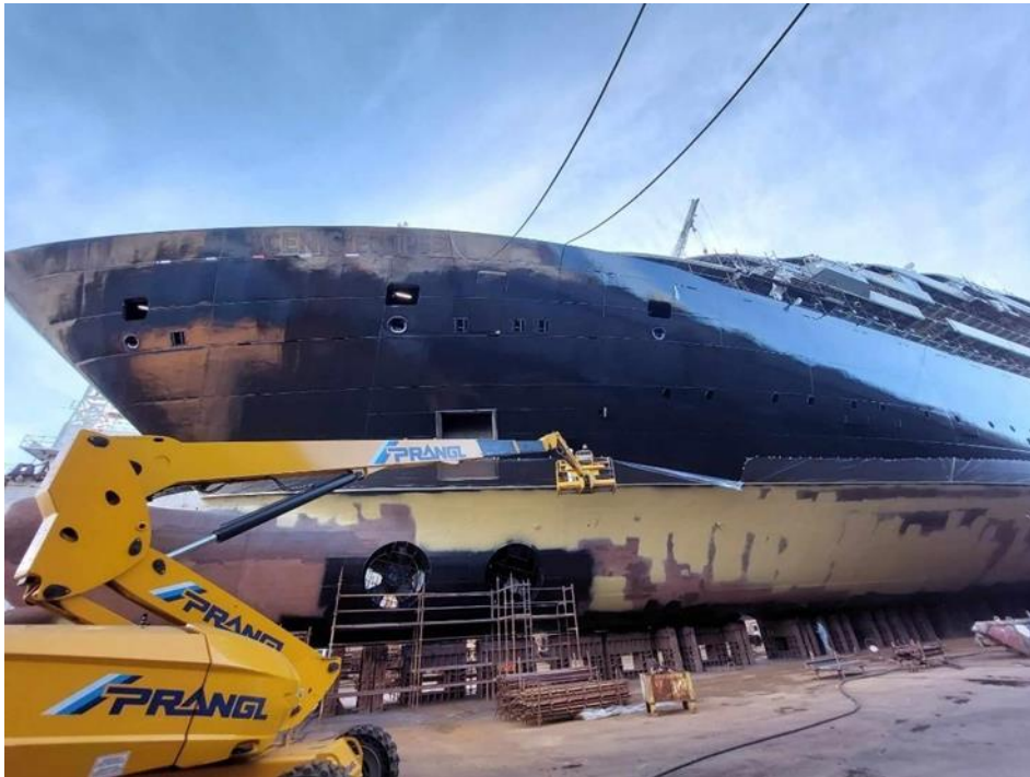
Slika 35. AKZ vanjske oplata broda u doku
