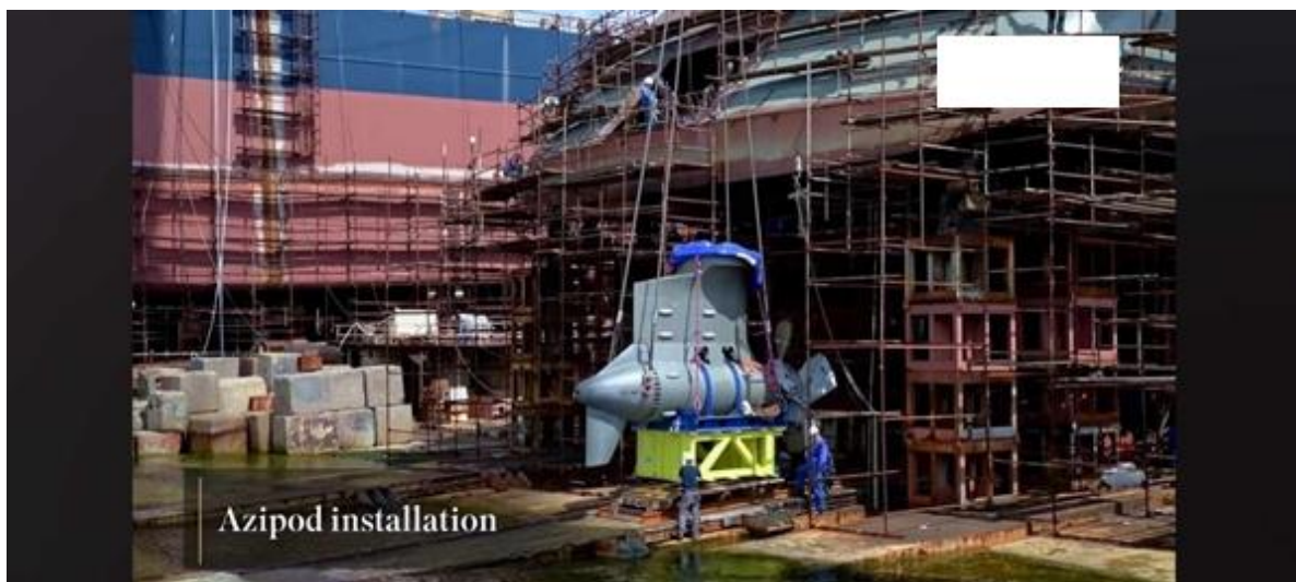
Slika 30. Montaža prouplzijskog sustava na navozu
