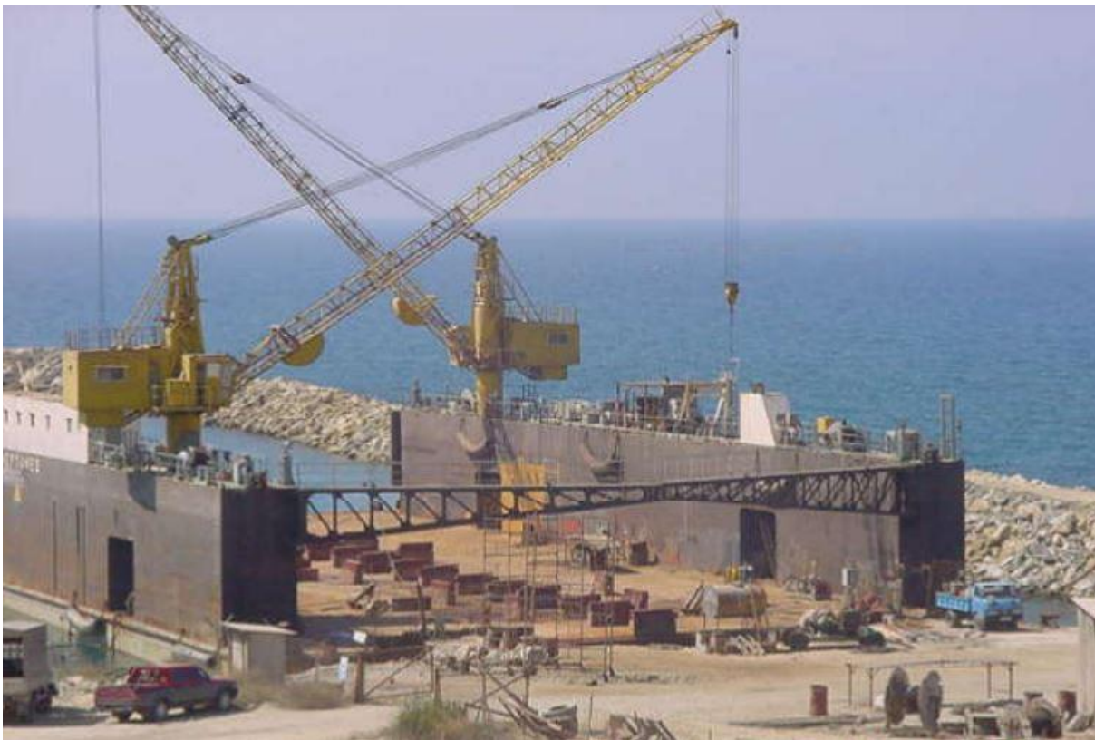
Slika 2.6. Monolitni plutajući dok [1]
