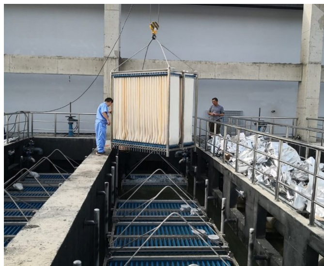
Slika 3.5. Prikaz zamjene membranskog modula (tzv. kazete)
