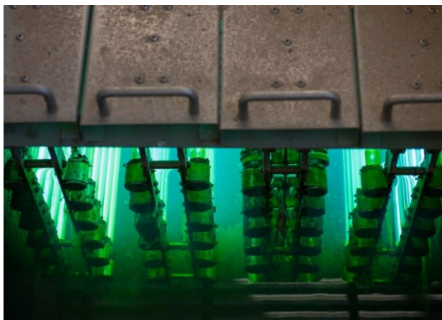
Slika 3.6. Prikaz modula UV lampi uronjenih u bazen s vodom [7]
