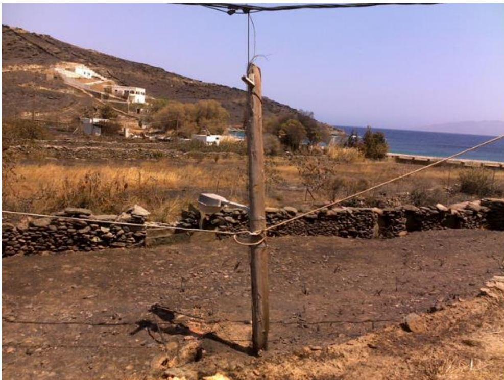
Slika 6.7. Izgorjeli drveni stup [18]
