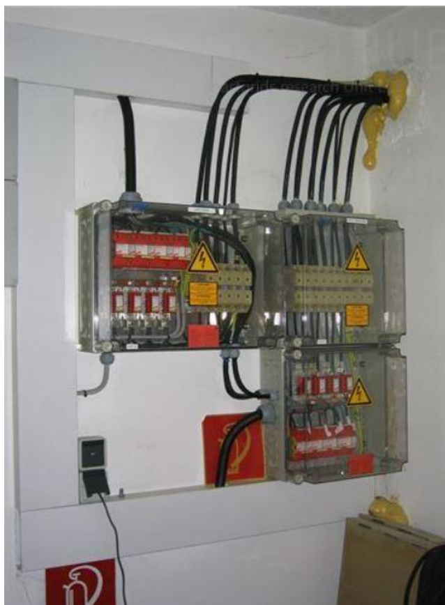
Slika 6.4. Razvodni ormarići [17]
