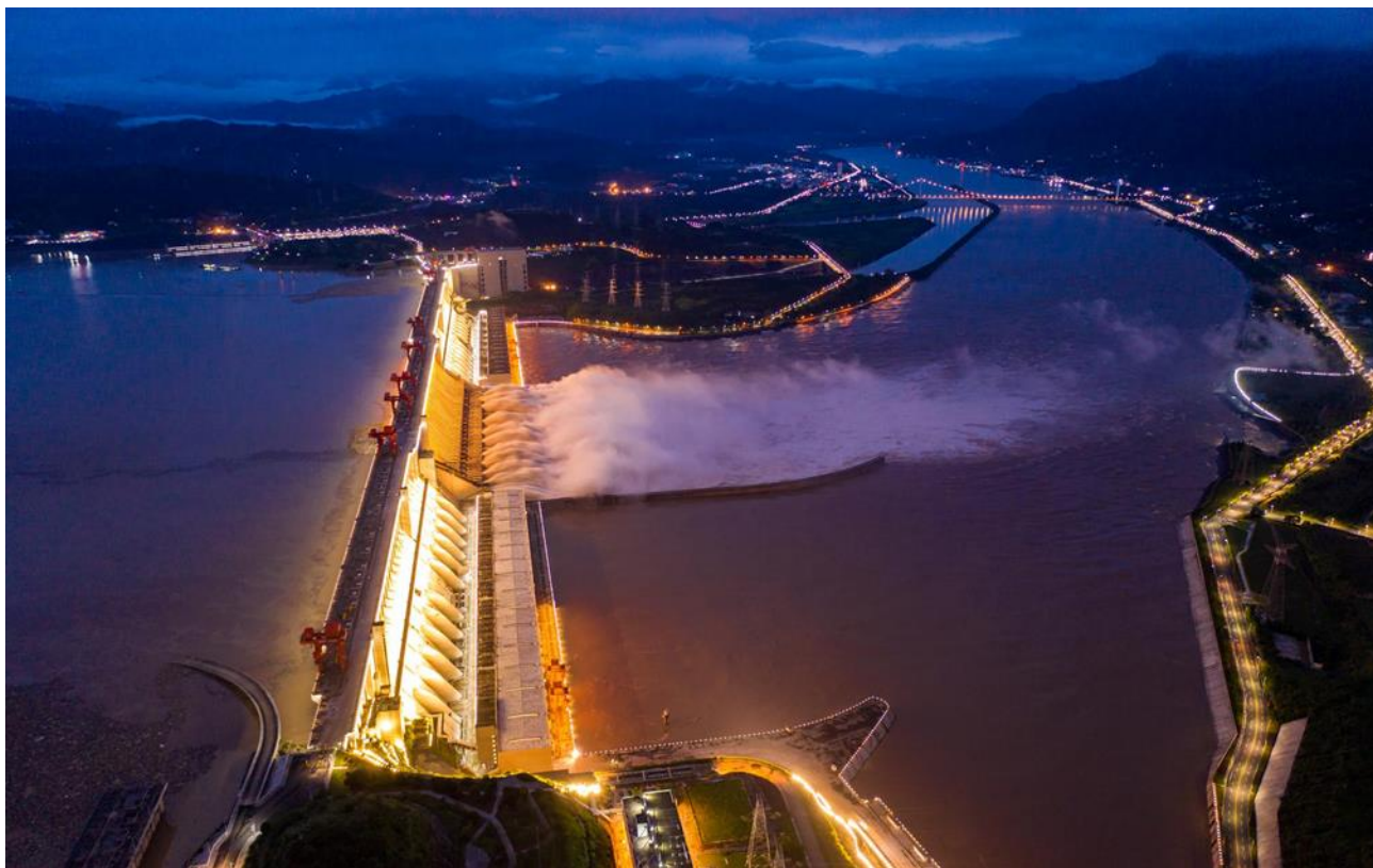
Slika 2.7. Velika hidroelektrana Tri klanca (Izvor: Jutarnji.hr)
