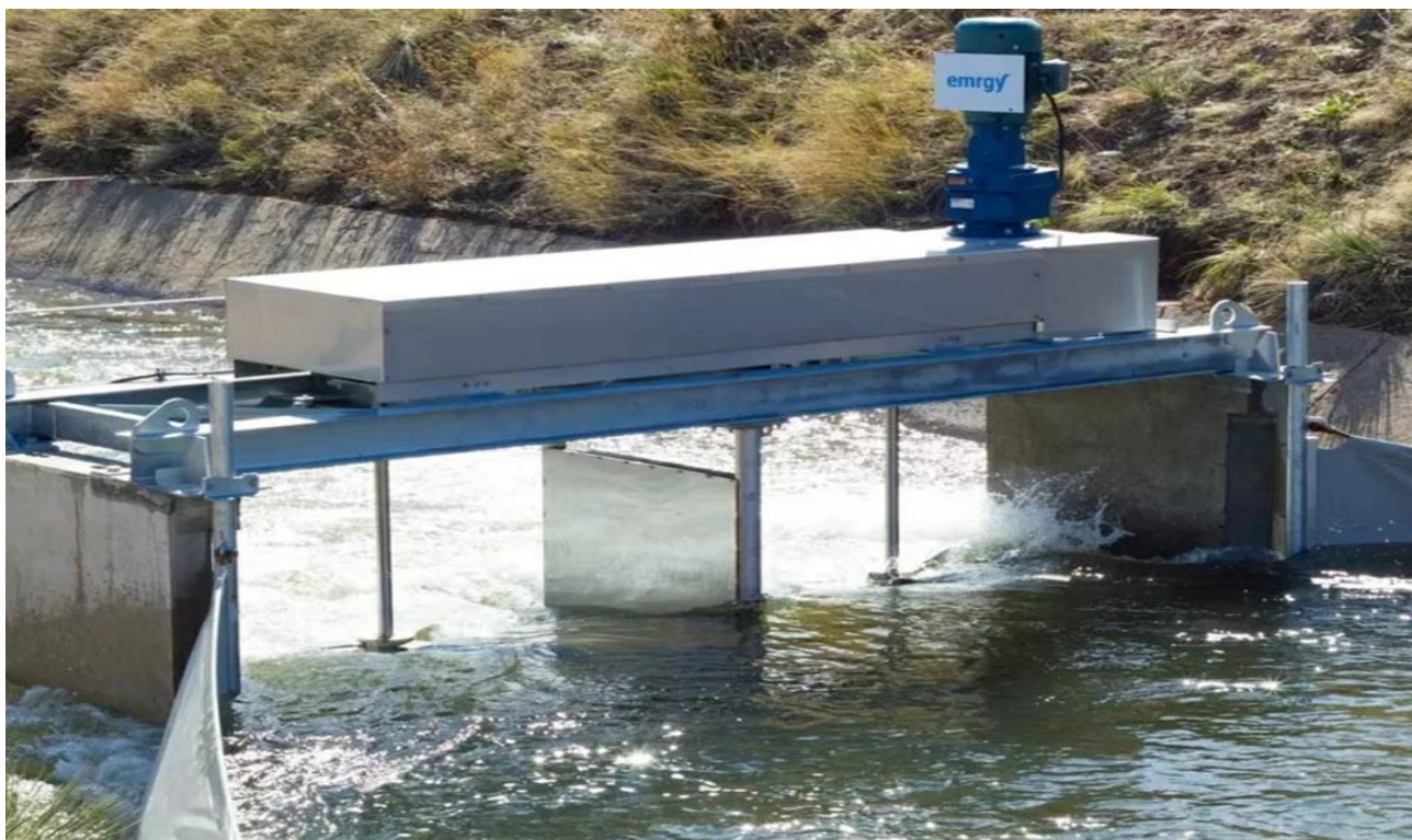
Slika 2.8. Mikro hidroelektrana (Izvor: hr.wikipedia.org)
