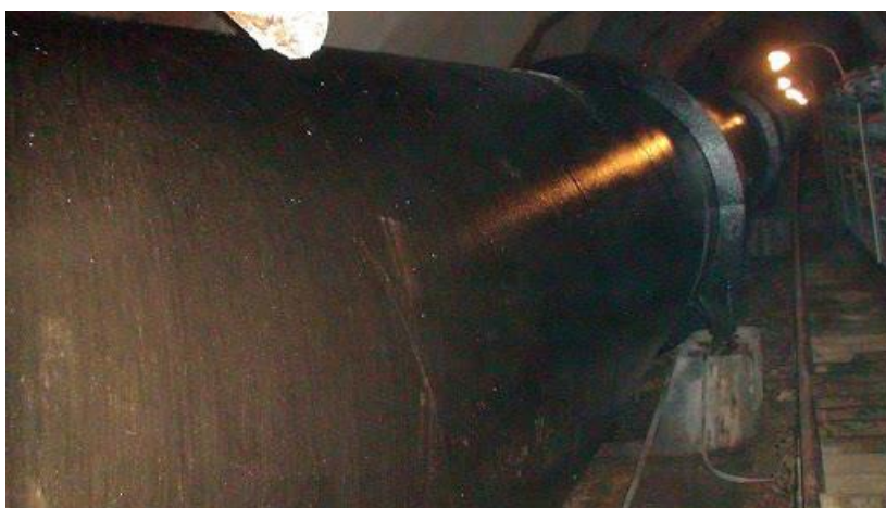
Slika 3.2. Tlačni cjevovod HE Rijeka (Izvor: hr.wikipedia.org)
