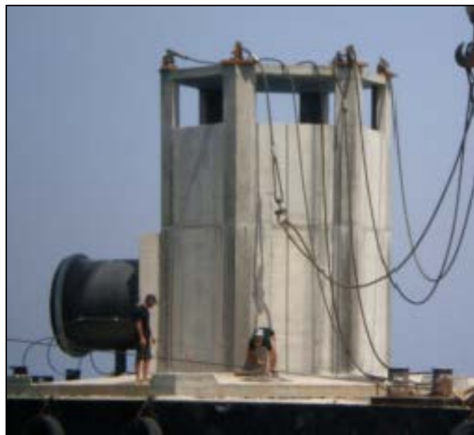
Slika 3.1 Usisno postrojenje (Alžir) [8]
