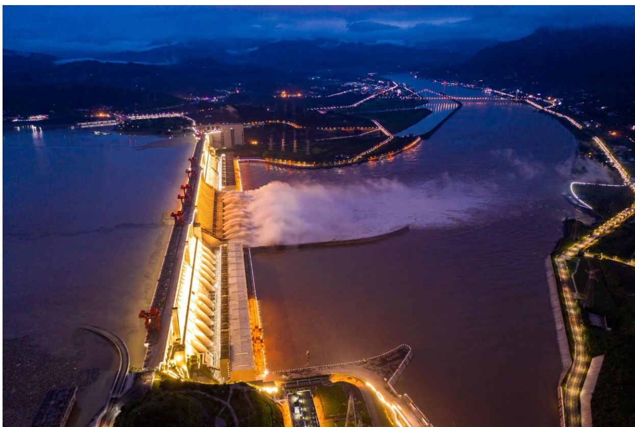
Slika 2.3. Najveća hidroelektrana na svijetu [12]
