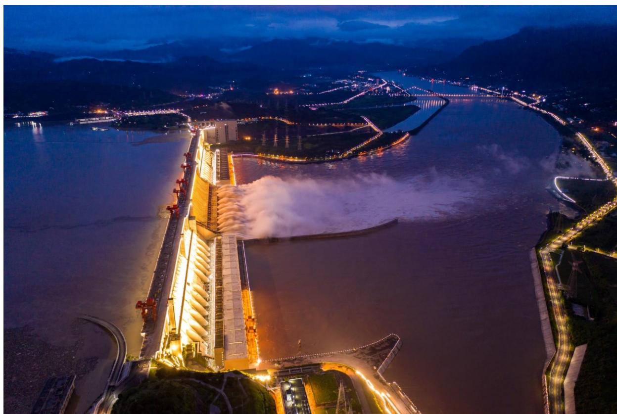
Slika 2.3. Najveća hidroelektrana na svijetu [12]
