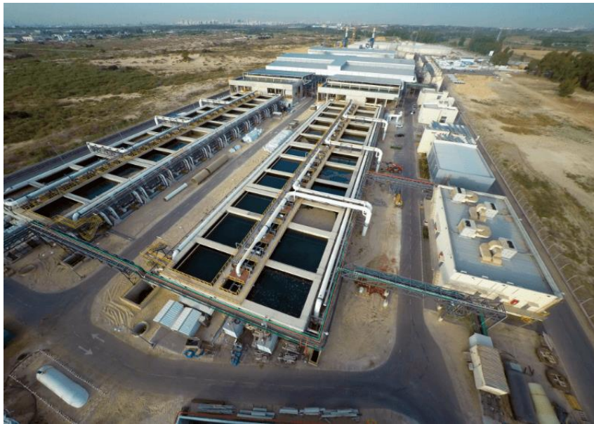
Slika 4.3. Desalinizacijsko postrojenje „Sorek“, Izrael [36]
