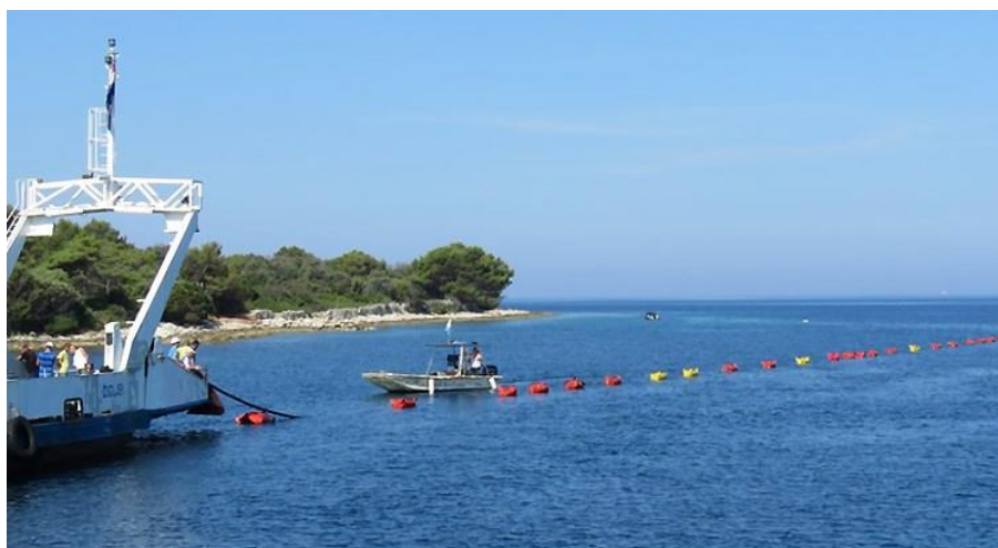
Slika 3.7. Polaganje kabela opremljenog plutućama [11]
