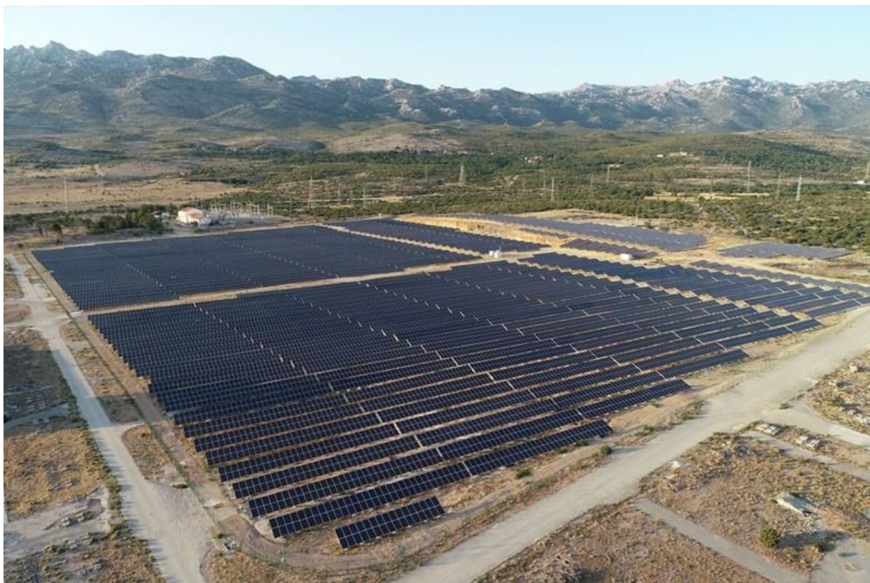
Slika 5.1.: Sunčana elektrana Obrovac [7]
