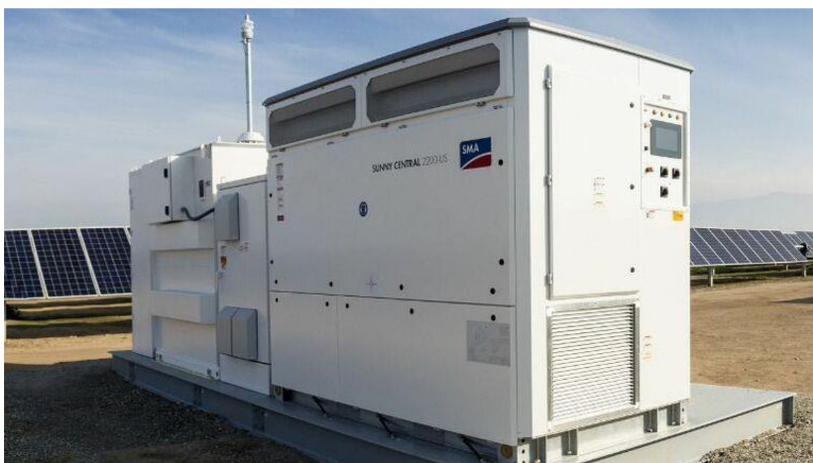
Slika 4.5.: Izmjenjivač SMA Sunny Central 2200
