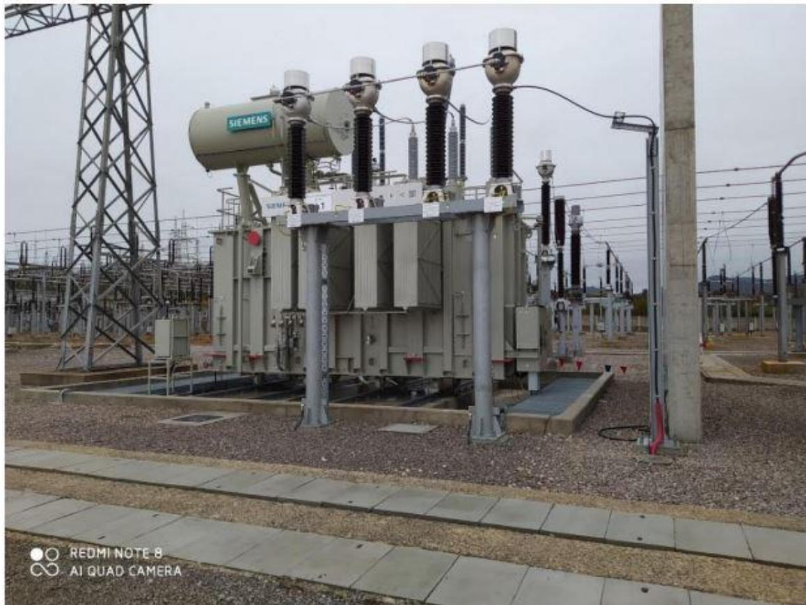
Slika 2.8. Prigušnica na visokom naponu u TS Melina [9]
