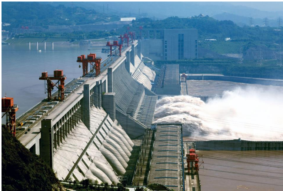
Slika 3.4 Hidroelektrana „Branja Tri klanca“, Kina [9]
