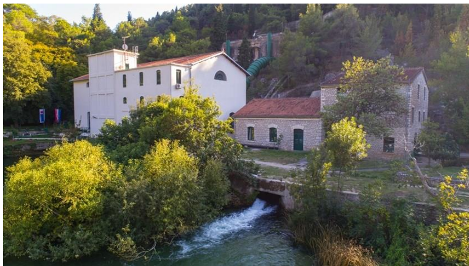
Slika 3.5 Hidroelektrana Jaruga, rijeka Krka [11]
