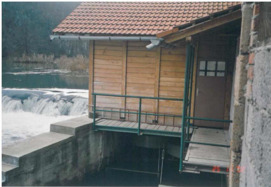
Slika 3.6 Mikro hidroelektrana Mataković [14]
