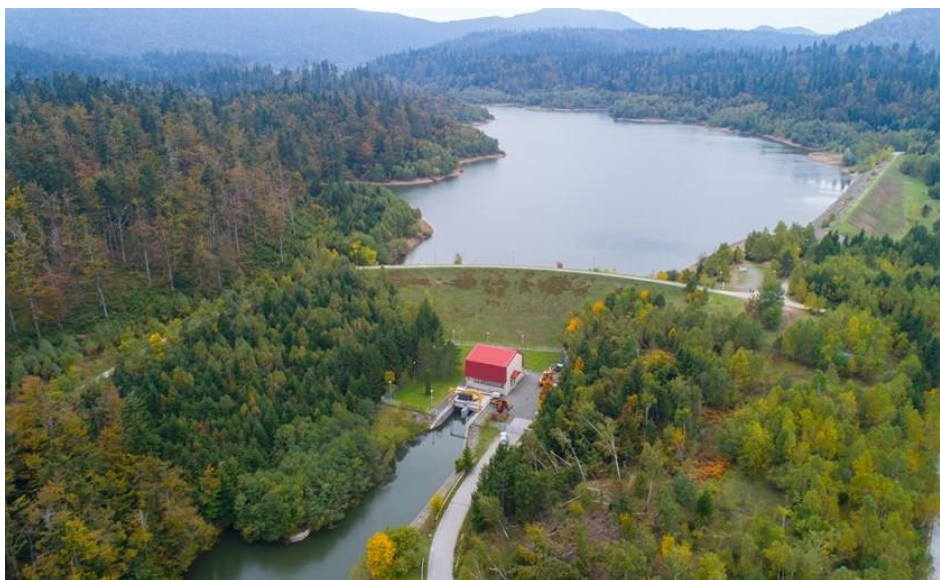
Slika 3.3 Reverzibilna hidroelektrana Lepenica, Fužine [7]
