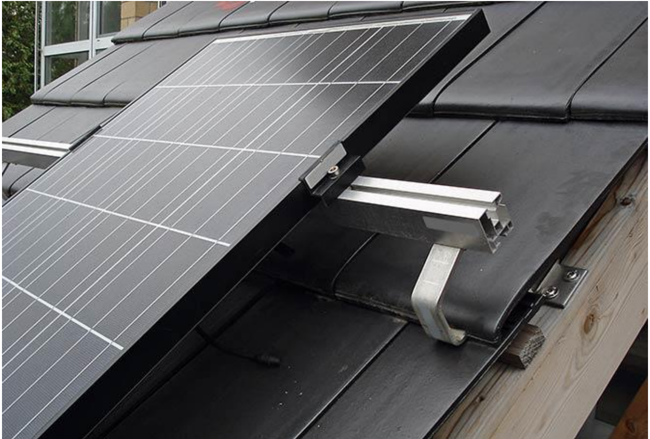
Slika 9.1 Ugradnja solarnog panela
