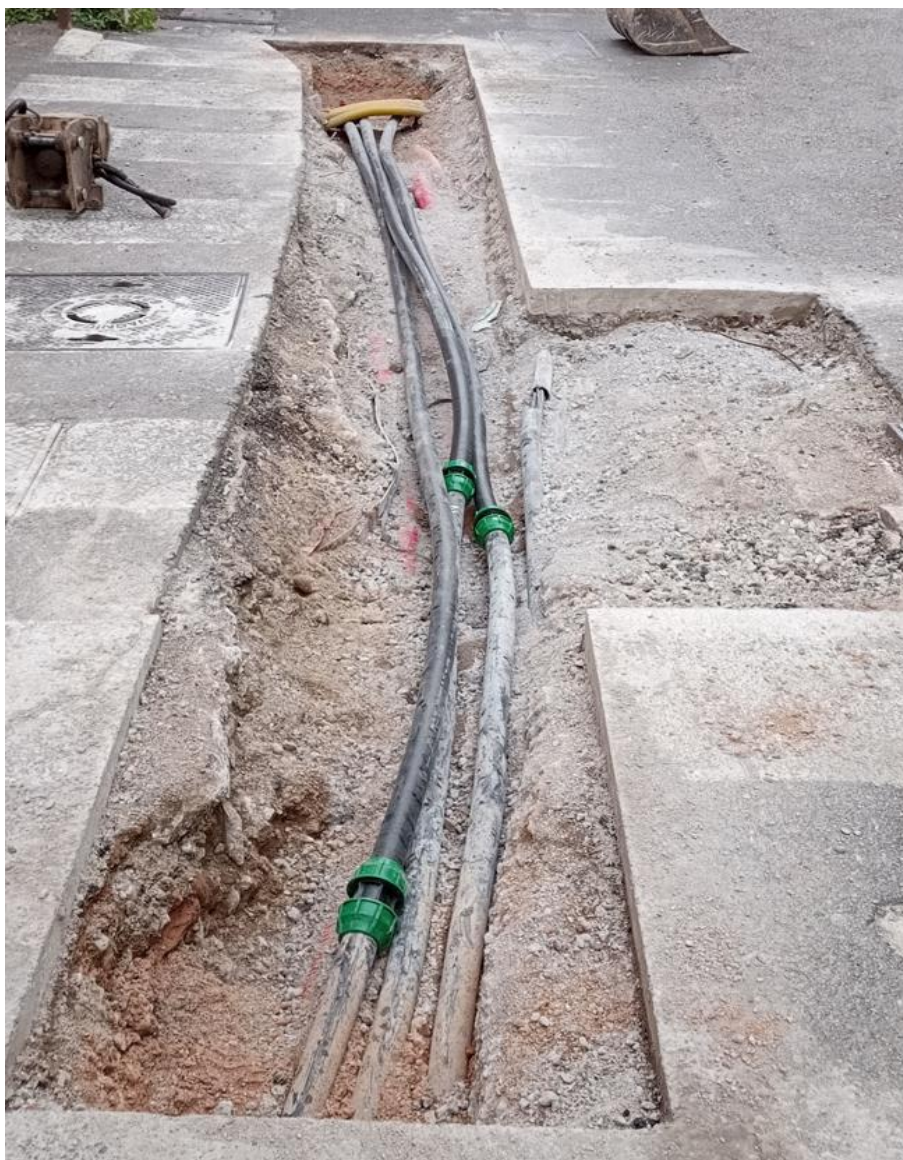
Slika 6.1. Položene PEHD cijevi za zaštitu optičkog voda
