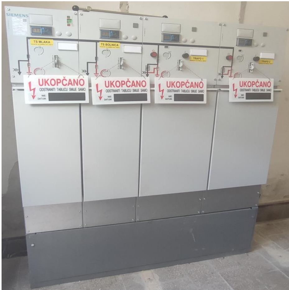
Slika 3.6. Izgled novog SN bloka
