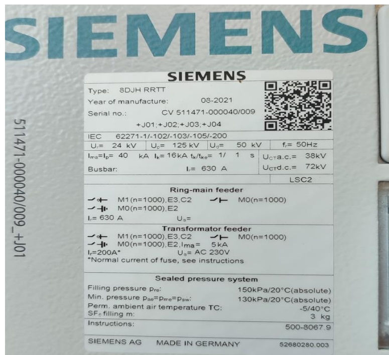
Slika 3.7. Natpisna pločica sa specifikacijama novog SN bloka
