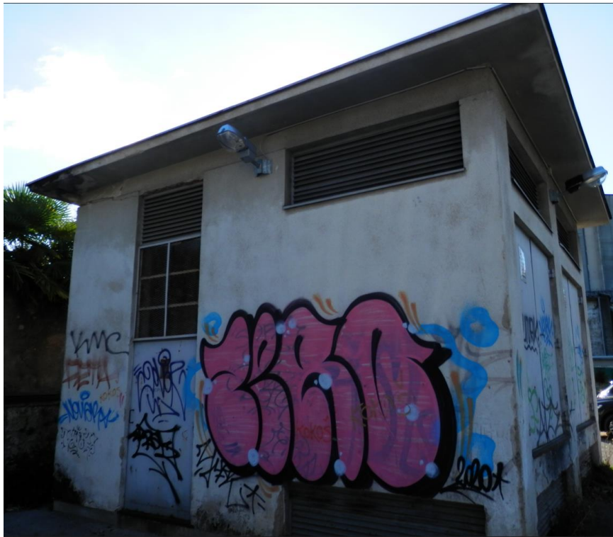
Slika 3.11. Vanjski izgled starije transformatorske stanice TS 10(20)/0,4 kV s ravnim krovom
