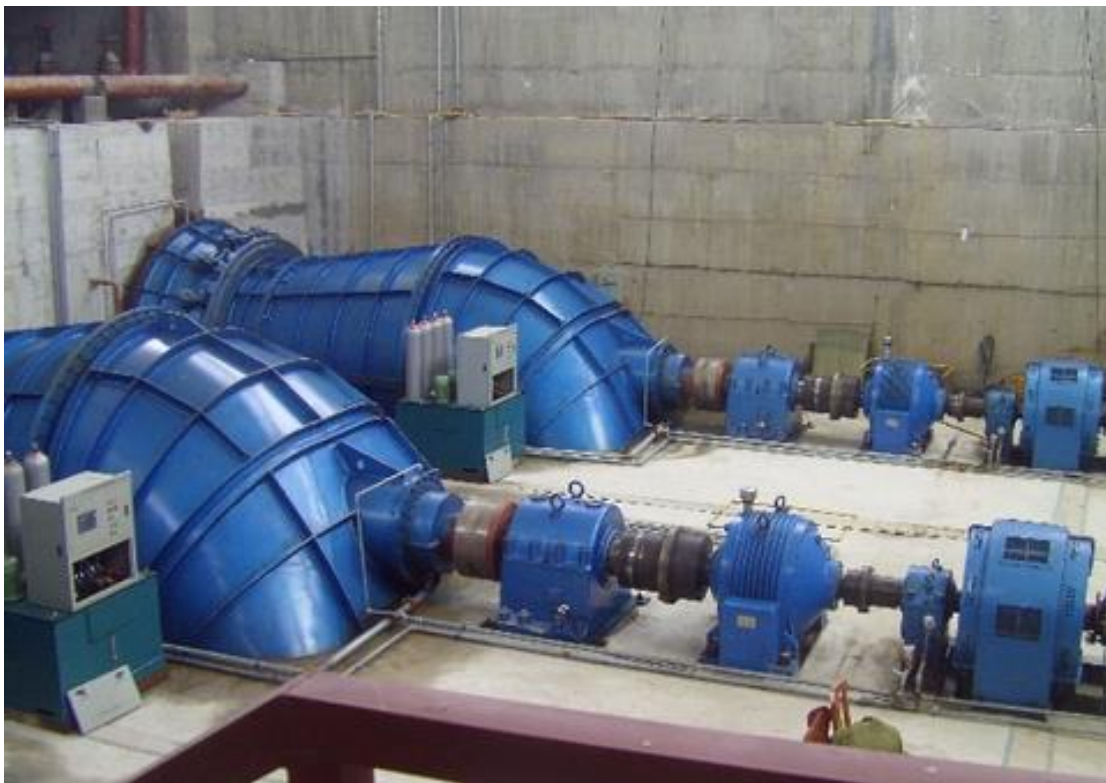
Slika 3.7 Cijevna turbina [9]
